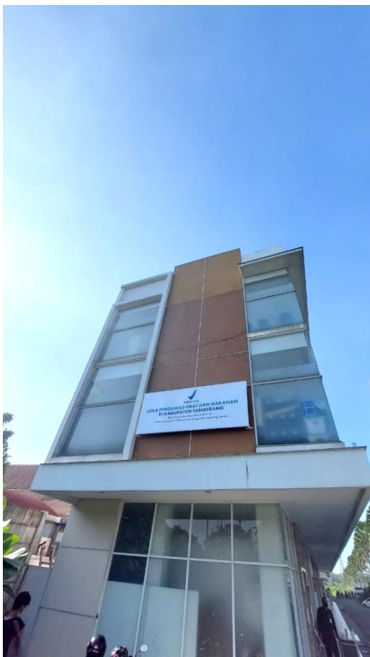
Gambar 3. Gedung Kantor Loka POM di Kabupaten Tangerang.
